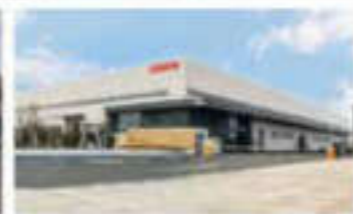
征和工业自动化部件(自行车链系统)工厂 Industrial Automation Parts (Bicycle chain system) Factory
